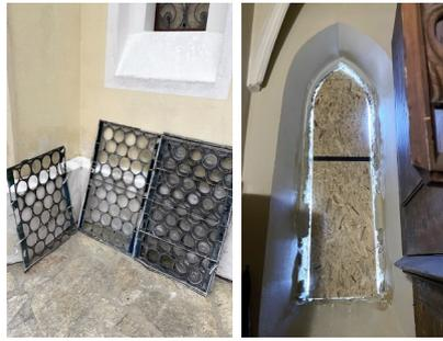
Die durchlöchernten Fensterteile mussten abgebaut und die Fensterluken abgedichtet werden
